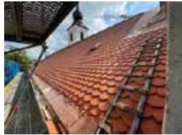
Ein Blick aufs Dach zeigt: Alles ist gut
