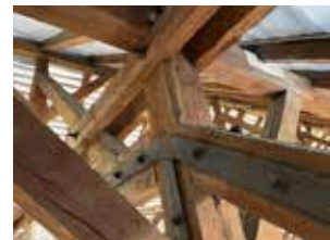
Stabiler Halt für unser Dach und unsere Gemeinde
